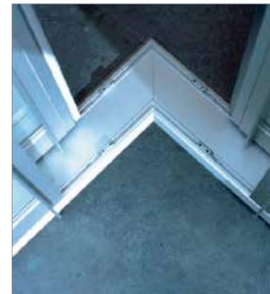
Bodenschiene als 90°- Ecklösung mit speziellen Eckprofilen an den Türrahmen. Es sind sowohl Innen- als auch Außen-Ecken planbar
