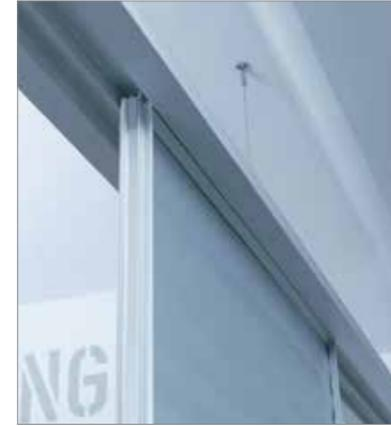
2-läufig abgehängte Deckenschiene
